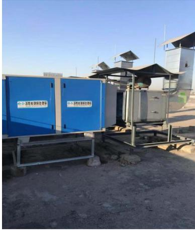
图9 项目废气治理设备照片、排口照片
