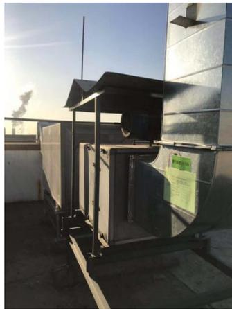
图10 减振措施照片
